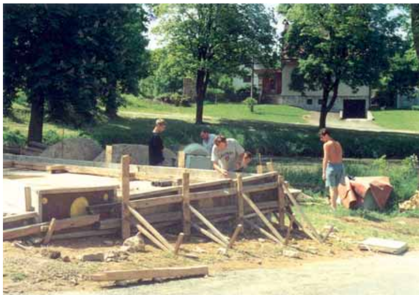
Stavba hasičské zbrojnice, 2001
