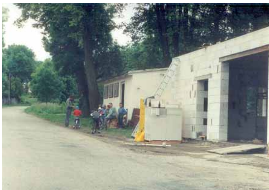
Stavba hasičské zbrojnice, 2001
