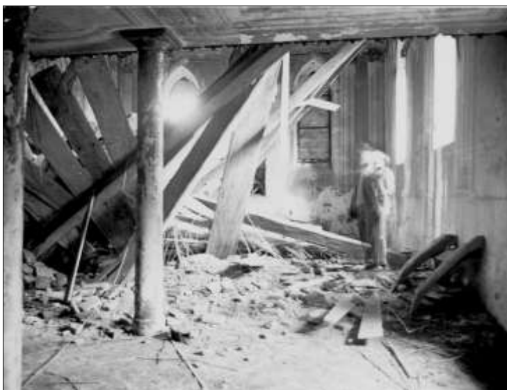
Zřícený strop, foto z r. 1968
