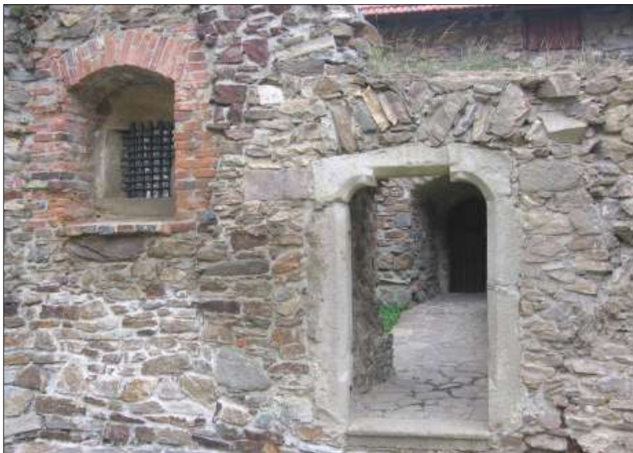
Sedlový portál z konce 15. století a okenní mříž na nádvoří straně zbytků východního křídla (obr. 1)
