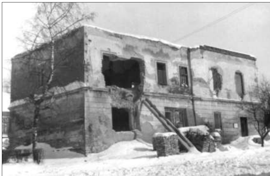
Vyhořelá budova okresního soudu před demolicí, přelom let 1945 a 1946, foto Vladimír Ferra (archiv KZHP)
