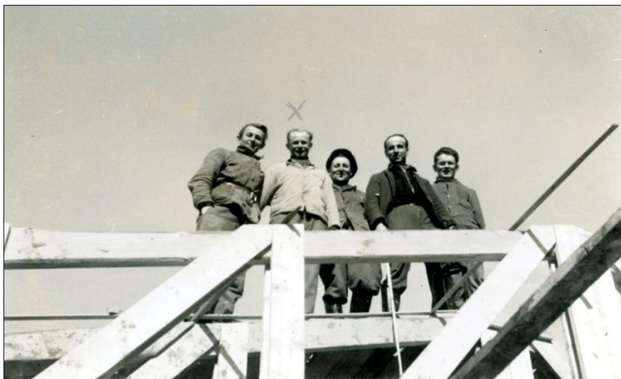
Skupina tesařů na některé ze staveb v lokalitě Mo i Rana. Ubytován byl tak, jako všichni totálně nasazení v typizovaných dřevěných domcích, na jejichž stavbě se jistě jako tesař podílel (rodinný archiv Mileny Brůhové)
