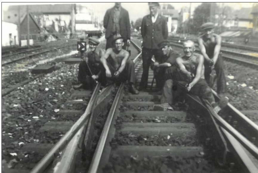
Čeští dělníci totálně nasazení na opravy a údržbu železničních tratí, druhý zprava Josef Drápela (pozůstalost J. Drápely)
